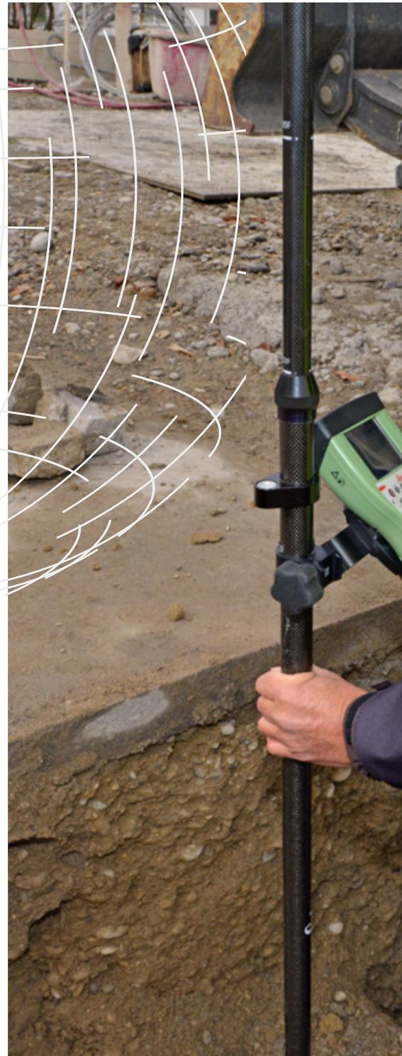
*Abwasserleitung an der Birmensdorferstrasse in Zürich kreuzt Gasleitung, die Abwasserleitung wird eingemessen.*
