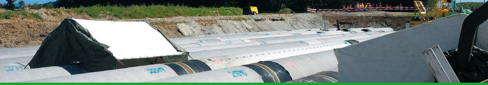
Röhrenspeicher in Urdorf. Die Erdgas-Speicheranlage hat eine Gesamtlänge von 4'140 Metern und kann mit einem nutzbaren Volumen von mehr als 700'000 Nm<sup>3</sup> befüllt werden.
