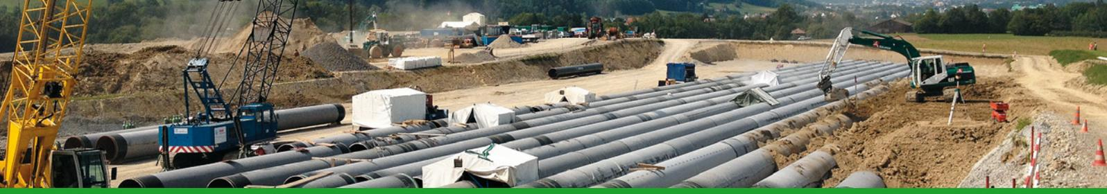
Röhrenspeicher in Urdorf. Über 250 Einzelrohre, die durchschnittlich 16 Meter lang sind und einen Durchmesser von rund 1,4 Metern aufweisen, wurden in der Baugrube verlegt.
