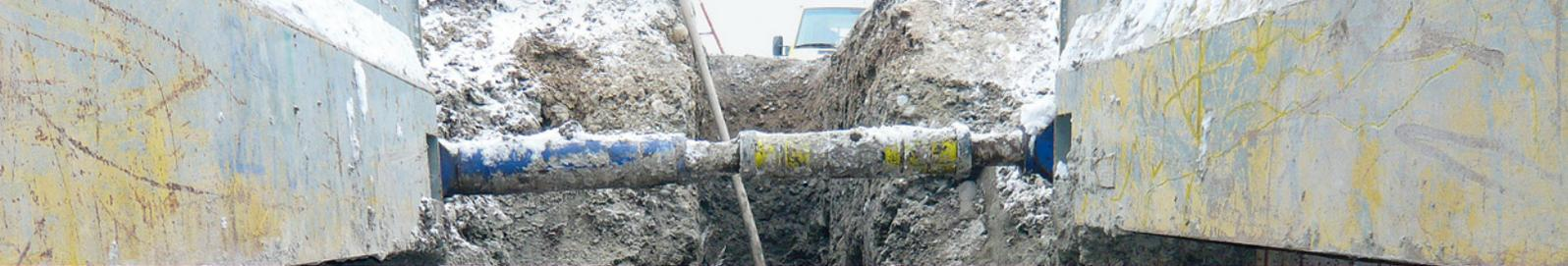
*Schutzrohrsanie rung in Wittenbach. Regelmässig durchgeführte Kontrollen haben ergeben, dass zwischen Schutzrohr und Hochdruckleitung eine elektrische Verbindung bestand. Um den kathodischen Korrosionsschutz nicht zu beeinträchtigen, wurde das Schutzrohr ausgebaut.*
