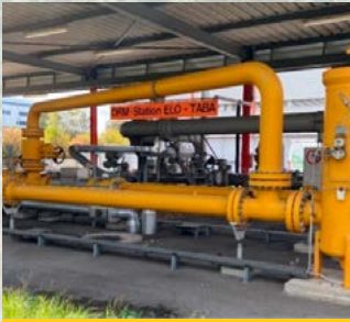
DRM-Station ELO-TABA, Umbau Umbau der Schiene 2 auf eine vollwertige Versorgungsschiene Status: Abgeschlossen 2022
