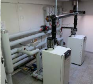
DRM-Station Flughafen Kloten, Heizungsumbau Heizungsumbau in der DRM-Station Status: Abgeschlossen 2022
